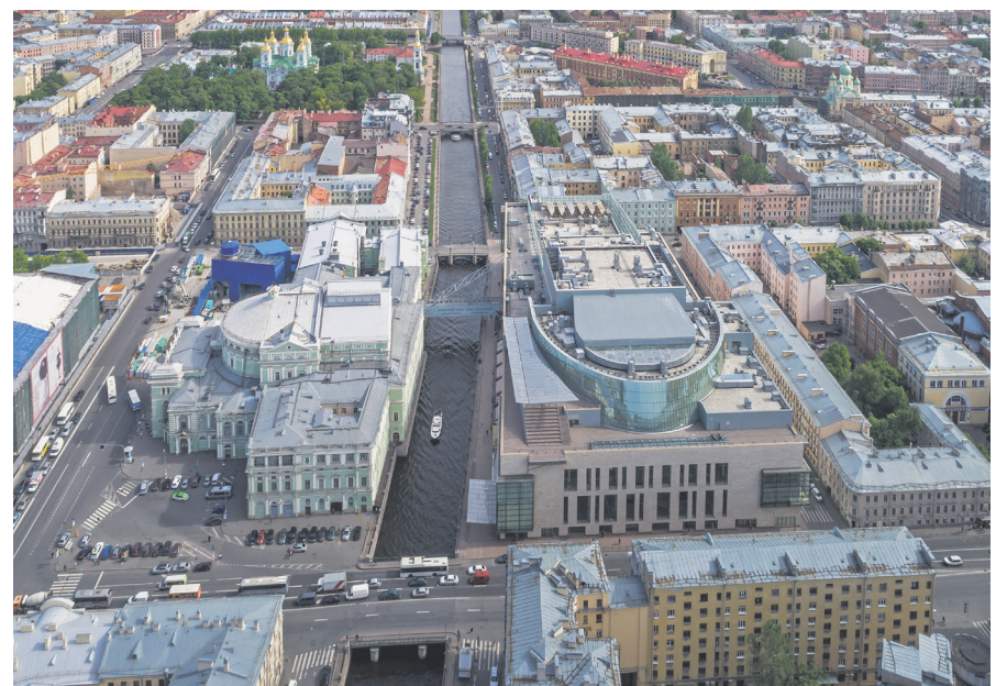
Peterburi Maria teatri teine saal on ehitatud ajaloolise hoone juurde (2013, Diamond and Schmitt Architects).
